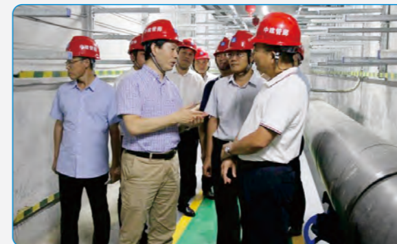
▲考评组查看建设一路管线入廊情况
