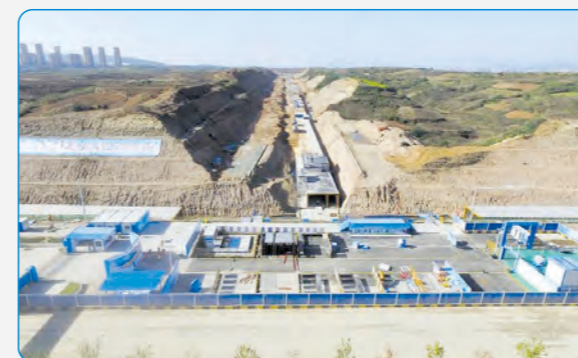
▲十堰生态滨江新区管廊项目（建设期拍摄）
